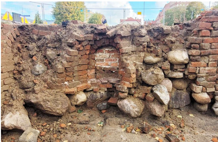
7. Sławno, piwnica „E” – północny fragment ściany wschodniej z pozostałościami pieca chlebowego. Od północy (po lewej stronie) partia ściany północnej z zamurowaną wnęką. Fot. A. Piwek, 2023 r.
