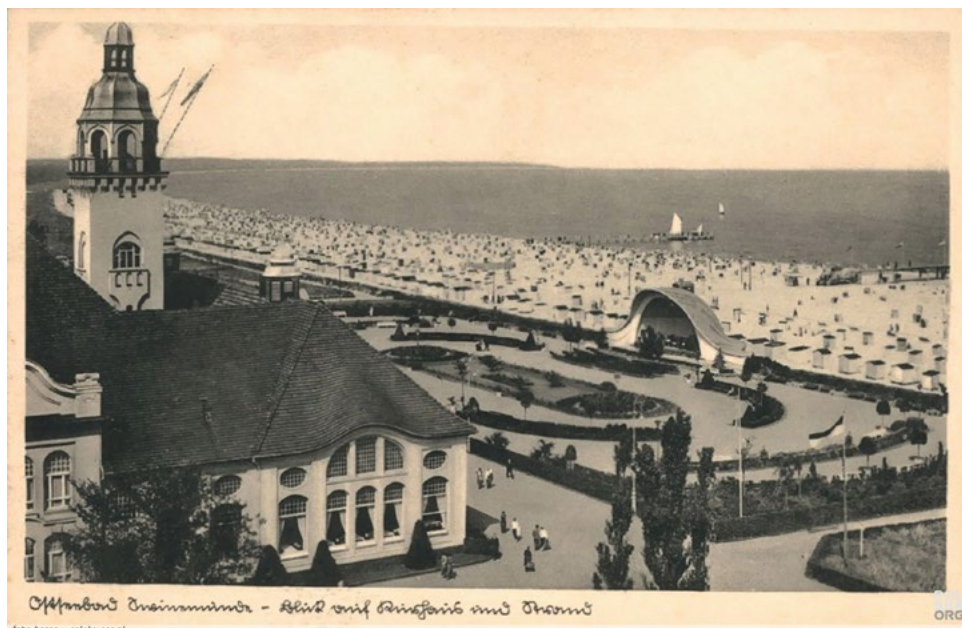
2. Widok „z lotu ptaka” na okolicę Domu Zdrojowego, z muszlą koncertową żelbetowej konstrukcji i placem koncertowym przy promenadzie, plażą i morzem w dalszym planie, 1932 r.
