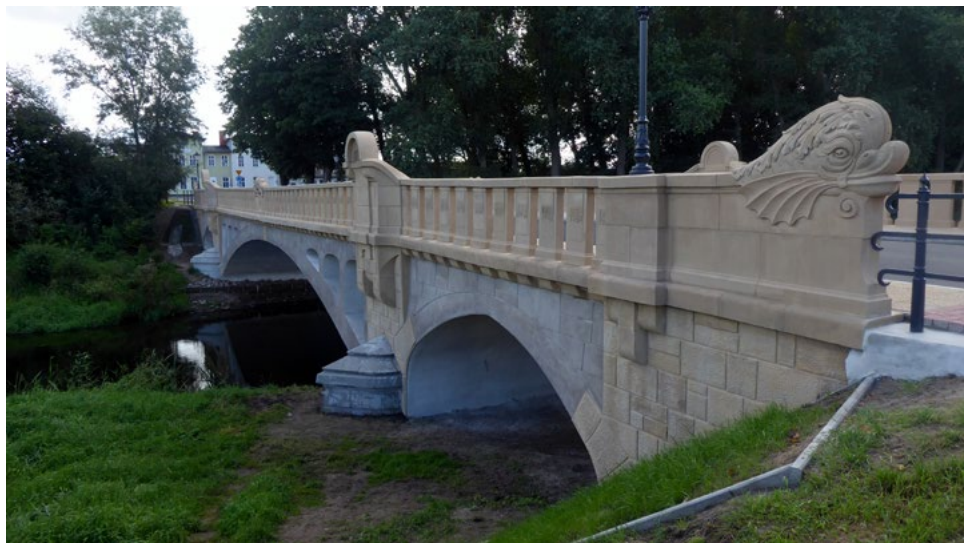
5. Północna część mostu – stan po konserwacji. Fot. M. Helińska-Grodź.
