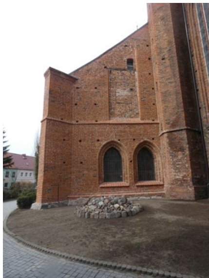
1. Kaplica Adoracji NS w Darłowie – elewacja wschodnia po zakończeniu prac. Fot. K. Bastowska, 2022 r.
