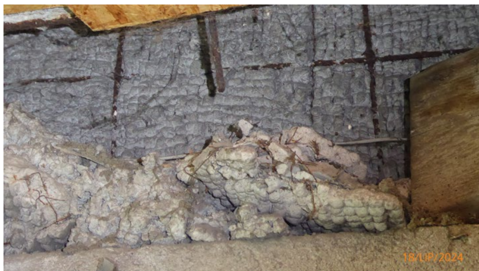
5. Fragment struktury budowlanej czaszy wewnętrznej, w części dolnej powłoki- widoczny od strony piwnicy betonowy natrysk na zbrojeniu z prętów stalowych powiązanych w siatkę. Fot. A. Hamberg-Federowicz, 2024 r.
