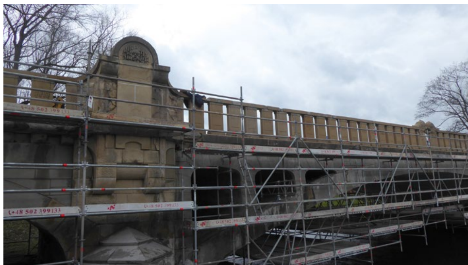
3. Montaż specjalnych rusztowań pozwalających na prowadzenie prac konserwatorskich ponad nurtem rzeki. Fot. M. Helińska-Grodź.
