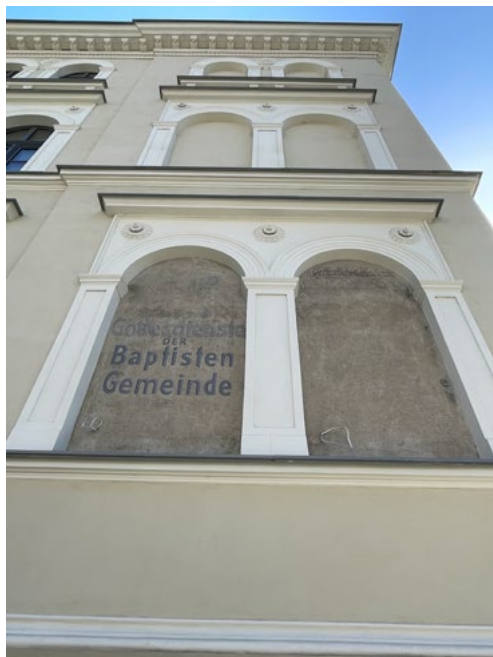
7. Nisza arkadowa z polichromią po renowacji oraz zrekonstruowany gzyms okapowy (fragment elewacji od ul. Kaszubskiej). Fot. W. Kokowski, 2024 r.
