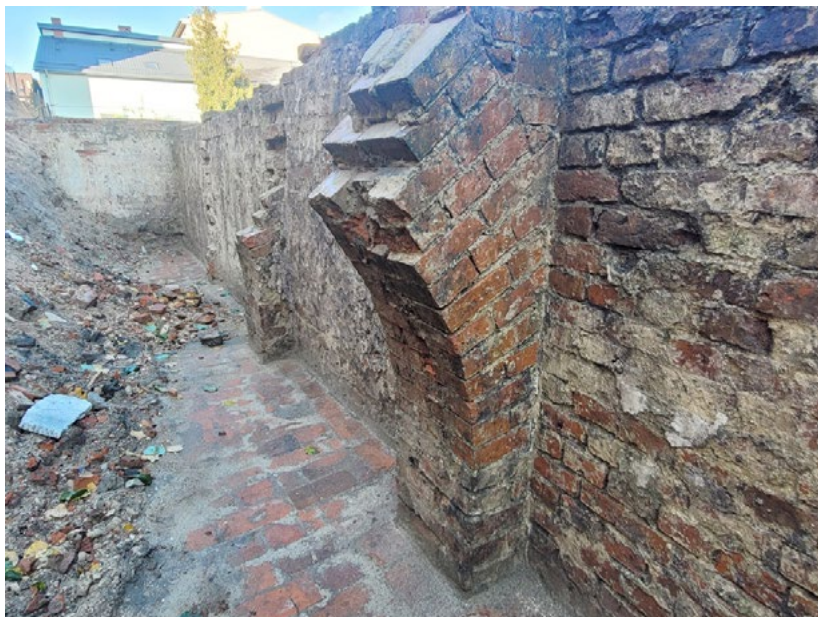
3. Sławno, piwnica „A” – widok w kierunku zachodnim na część ściany północnej z fragmentami trzech łęków i posadzką ceglana. Fot. A. Piwek, 2023 r.
