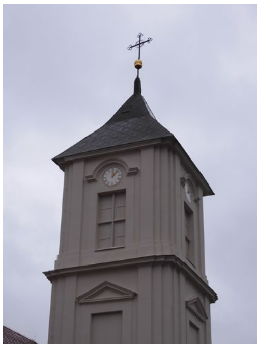
3. Górna kondygnacja wieży. Stan po remoncie. Fot. Zbigniew Kocur, 2024 r.
