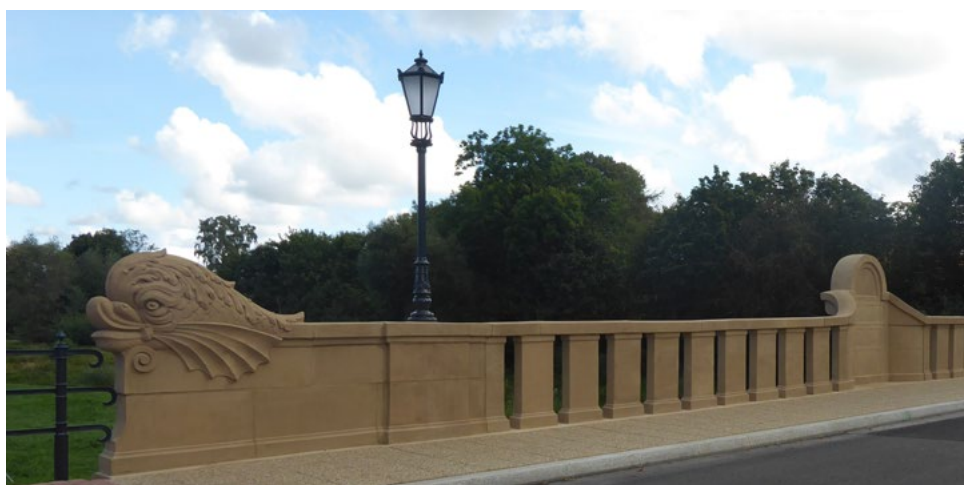
6. Balustrada mostu z zamontowaną latarnią – stan po konserwacji. Fot. M. Helińska-Grodź.
