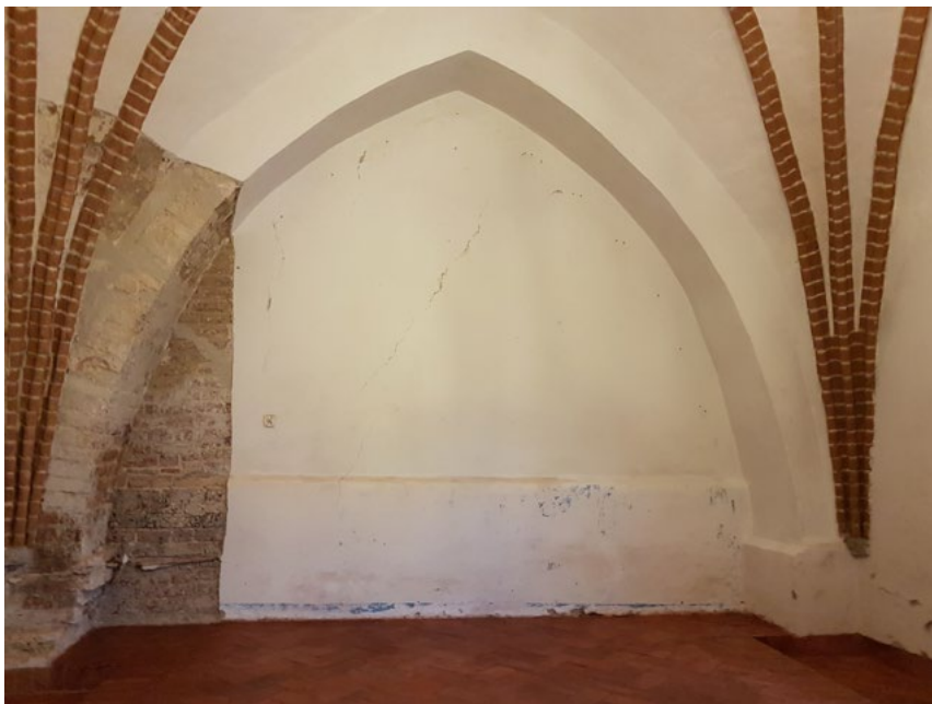
4. Kaplica Adoracji NS w Darłowie – wnętrze, ściana północna w trakcie odkrywek z widocznym fragmentem zacheuszką. Fot. K. Bastowska, 2018 r.
