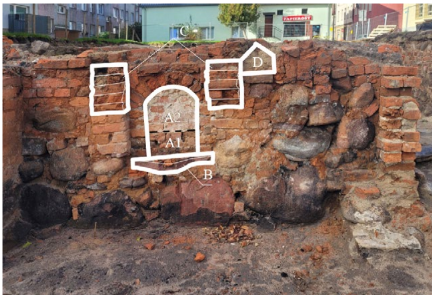
6. Sławno, piwnica „C” – ściana zachodnia z relikami pieca chlebowego. Obwiedzione partie należą do jego konstrukcji: A1 – podmurowanie otworu wsadowego, A2 – zamurowanie otworu wsadowego, B – płyta kamienna, C – wsporniki na osadzenie okapu, D – zamurowany otwór wentylacyjny. Fot. A. Piwek, 2023 r.
