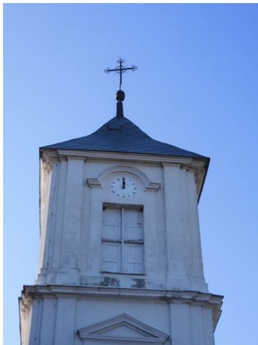
2. Górna kondygnacja wieży. Stan przed remontem. Fot. Zbigniew Kocur, 2024 r.
