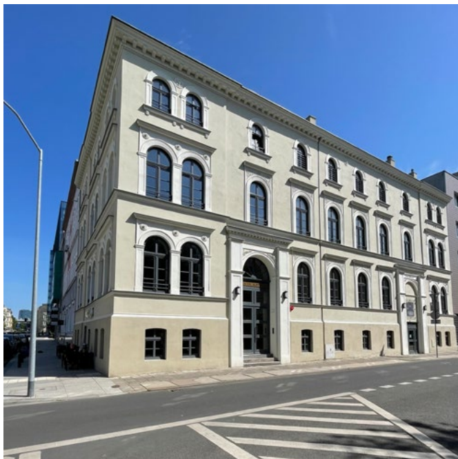
5. Elewacja od ulicy Stożkowa, stan po zakończeniu prac konserwatorskich. Fot. W. Kokowski, 2024 r.
