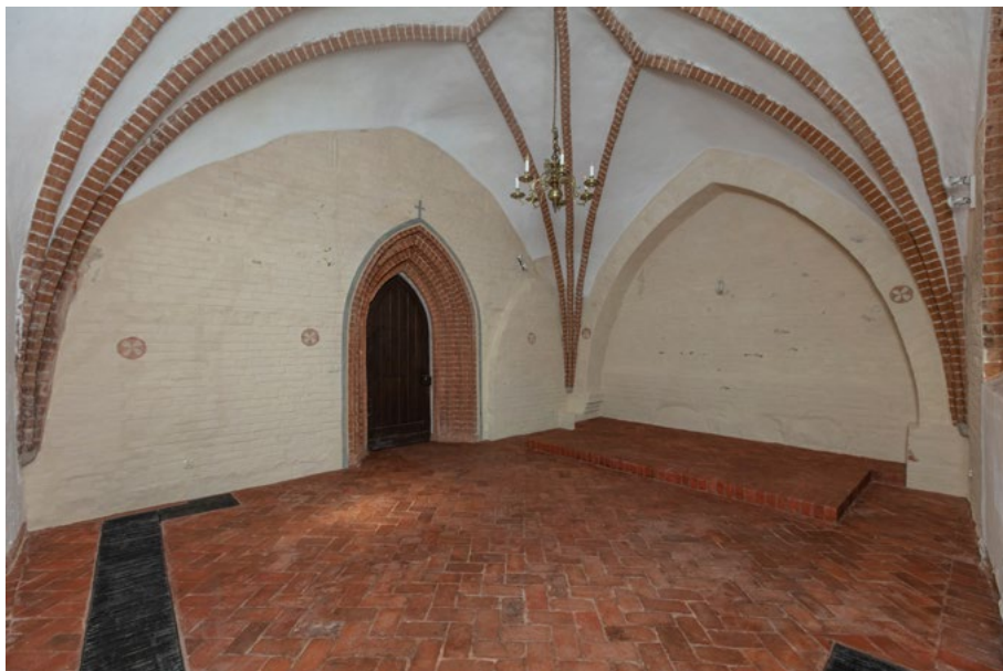
6. Kaplica Adoracji NS w Darłowie – wnętrze, widok na ściany północną (prezbiterialną) i zachodnią (nawa pd.) po zakończeniu prac konserwatorskich. Fot. M. Caban 2020 r.
