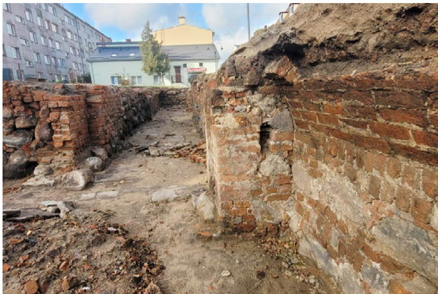
5. Sławno, piwnica „C” – ceglane wysunięcie ze ściany północnej z pozostałościami sklepienia kolebkowego. W głębi, na ścianie południowej korytarza prowadzącego do piwnicy „D”, pozostałości po wnęce. Pobliską posadzkę tworzą płyty betonowe. Fot. A. Piwek, 2023 r.
