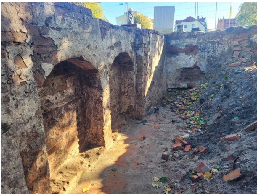
2. Sławno, plac Kard. Stefana Wyszyńskiego – piwnica „A” – widok w kierunku wschodnim na część ściany północnej z dwiema wnękami domkniętymi łękami odcinkowymi. Posadzka składa się z cegieł ułożonych poprzecznie do tej ściany. Fot. A. Piwek, 2023 r.
