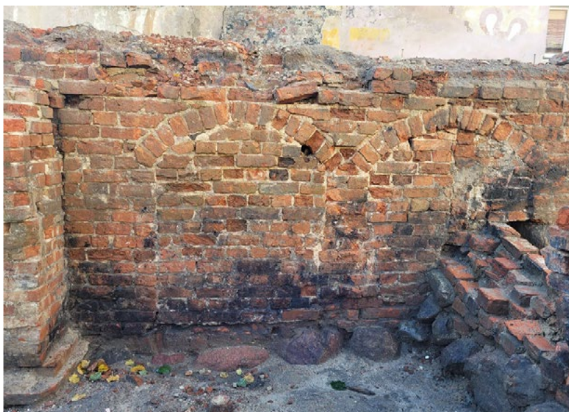
4. Sławno, piwnica „B” – południowo-zachodni fragment ściany południowej z dwiema zamurowanymi wnękami. Od wschodu (po lewej stronie) do niej dostawiony jest filar przyścienny, zaś od zachodu (po prawej stronie) wąska ściana zachodnia. Fot. A. Piwek, 2023 r.
