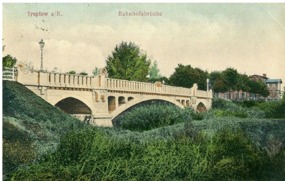
1. Widok drogowego mostu nad Regą w Trzebiatowie – stan sprzed 1945 r. Źródło: www.fotopolska.eu
