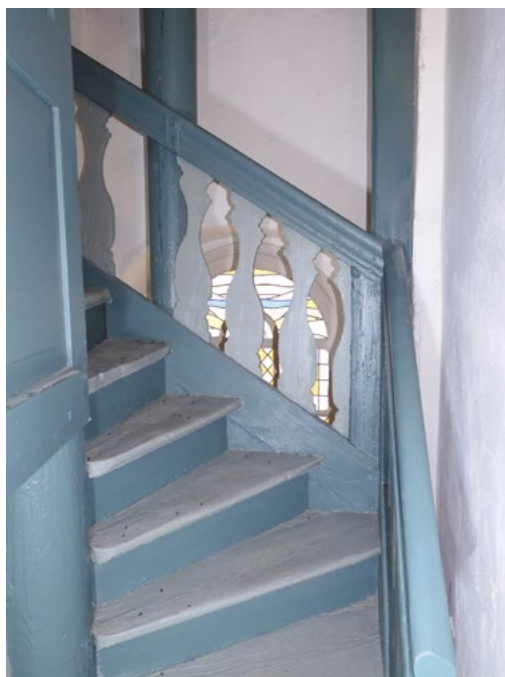
9. Schody wewnętrzne. Stan po remoncie. Fot. Zbigniew Kocur, 2024 r.
