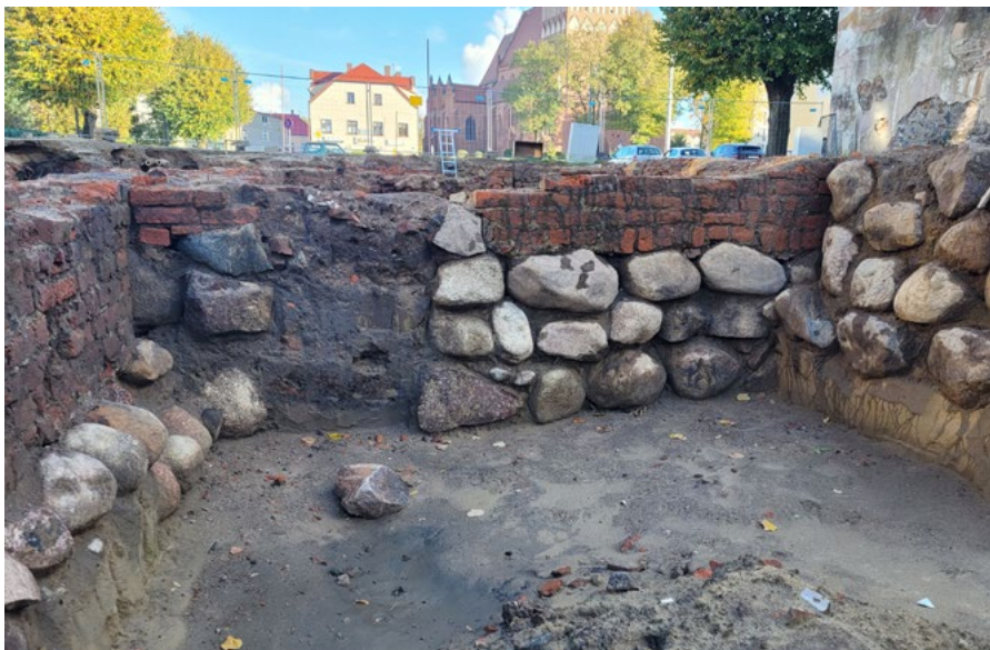
8. Sławno, piwnica „F” – północna część ściany wschodniej z zasypnym wejściem do piwnicy „E”. Od północy (po lewej stronie) ceglane zamurowanie wybitego przejścia do małego pomieszczenia piwnicy „D”. Po przeciwnej stronie fragment dostawionej ściany kamiennej należącej do zabudowy gospodarczej. Fot. A. Piwek, 2023 r.
