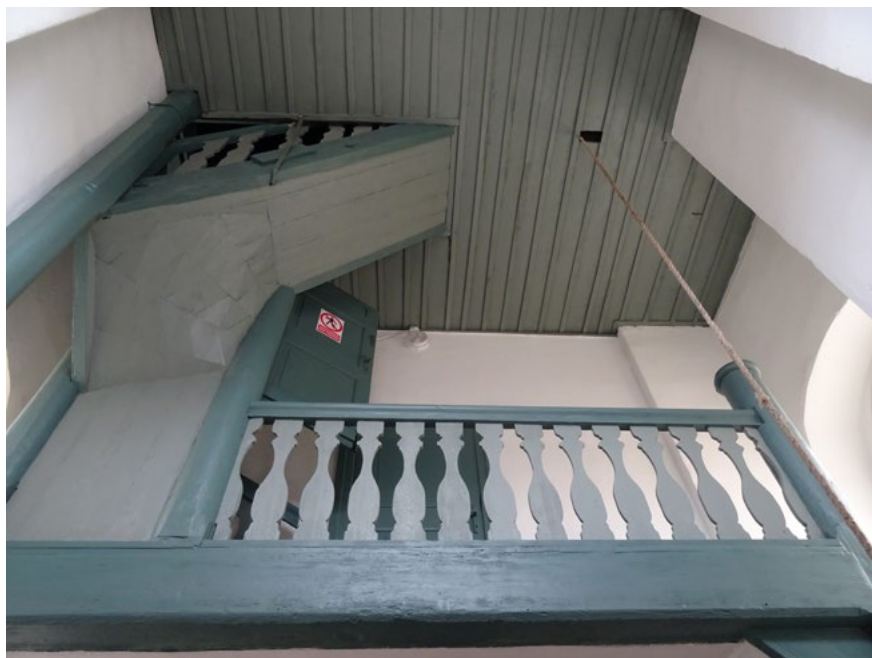
7. Schody wewnętrzne, balustrady i strop ponad pierwszą kondygnacją wieży. Stan po remoncie. Fot. Zbigniew Kocur, 2024 r.
