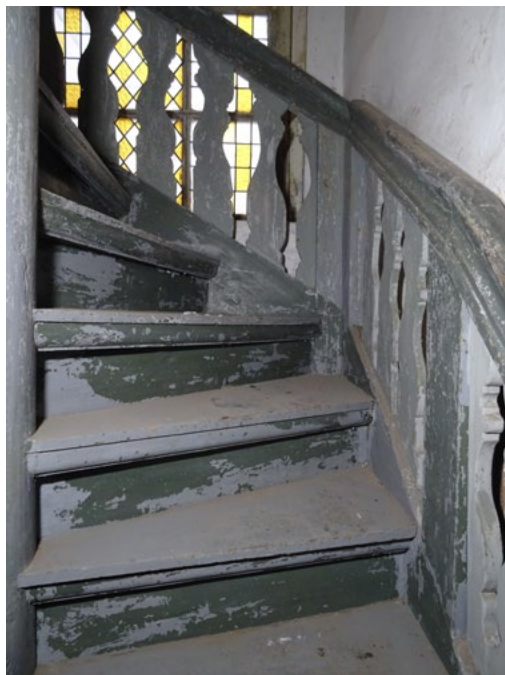
8. Schody wewnętrzne. Stan przed remontem. Fot. Zbigniew Kocur, 2024 r.
