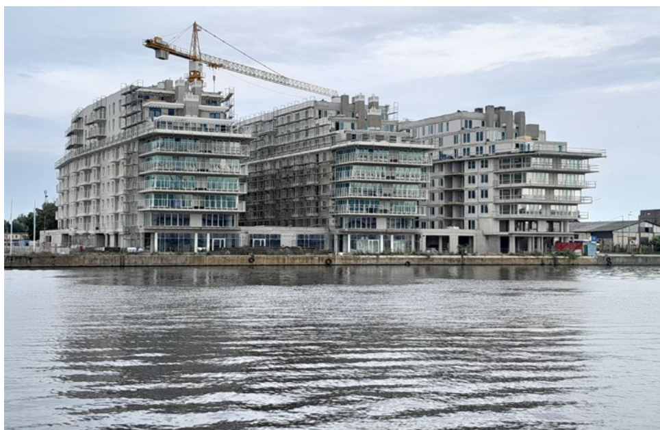
8. Kępa Parnicka, zespół nowej zabudowy wzdłuż Bulwaru Elbląskiego nad Odrą, w trakcie budowy. Fot. B. Kosińska, 2024 r.
